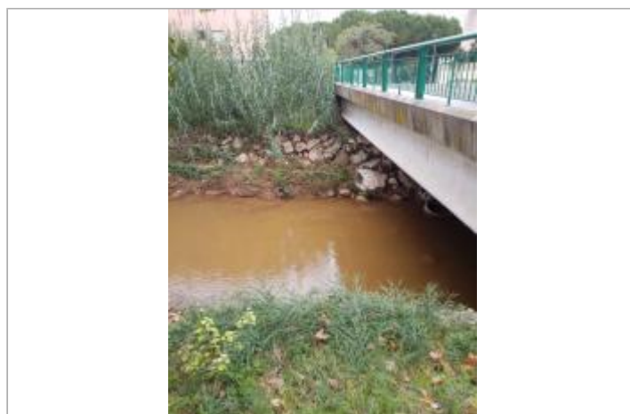
Vue du site - Auteur : Cerema Méditerranée
