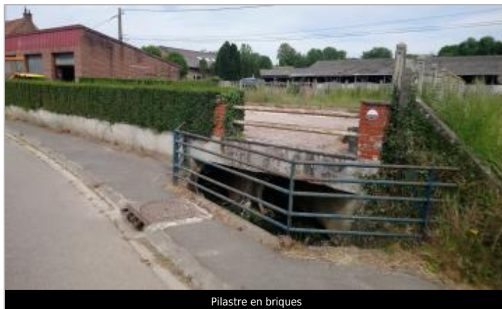
Pilastre en briques
