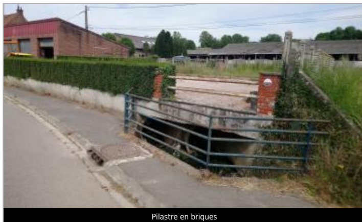
Pilastre en briques
