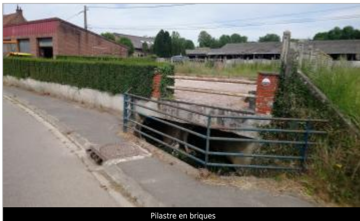
Pilastre en briques
