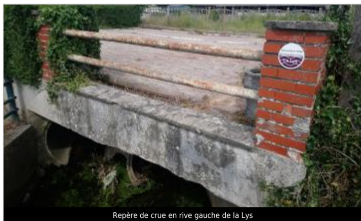
Repère de crue en rive gauche de la Lys
