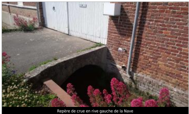
Repère de crue en rive gauche de la Nave
