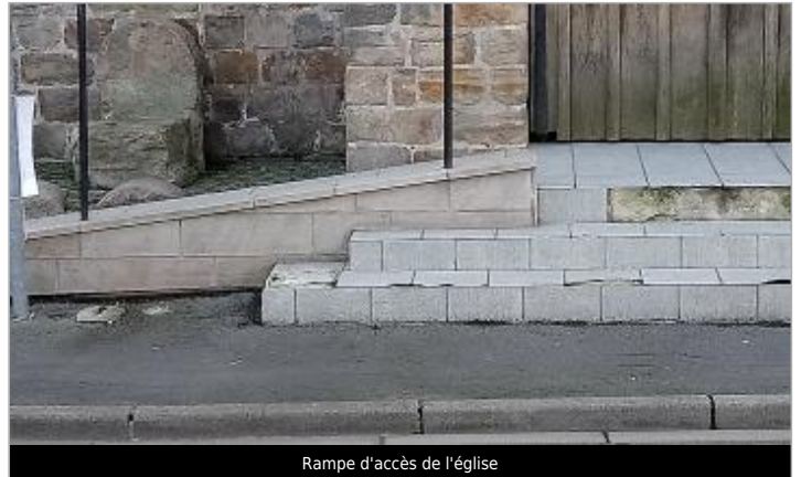
Rampe d'accès de l'église
