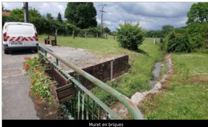
Muret en briques
