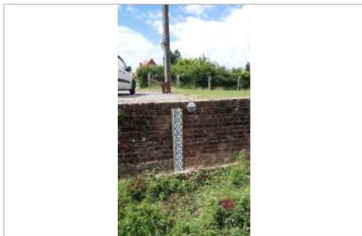
Repère de crue en rive gauche de la Lawe
