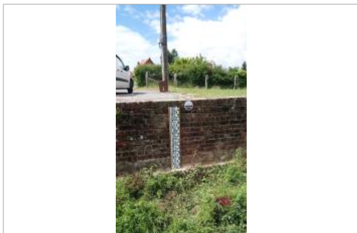
Repère de crue en rive gauche de la Lawe
