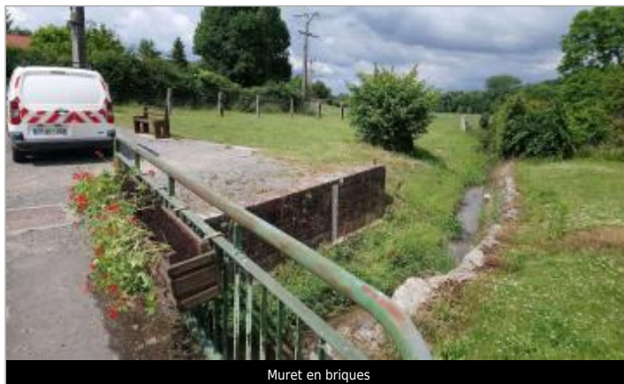
Muret en briques
