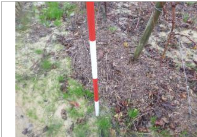
Berge rive droite vigne - Photo © AGERIN
