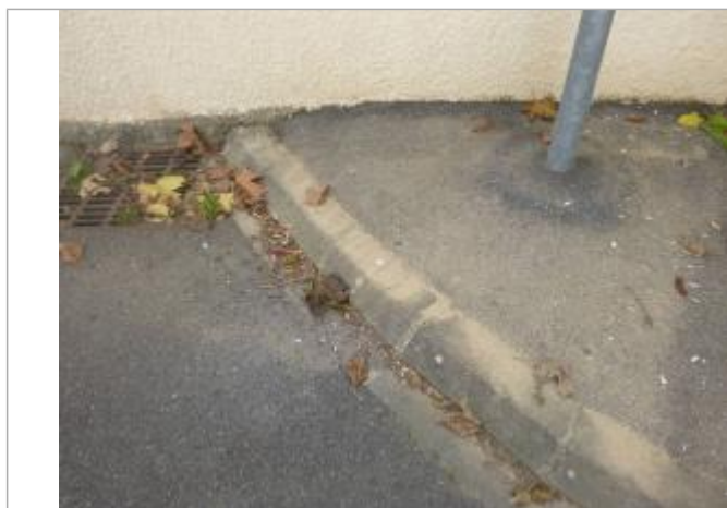
Berge rive droite - Photo ©AGERIN
