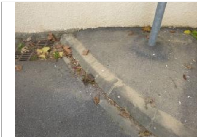
Berge rive droite - Photo ©AGERIN
