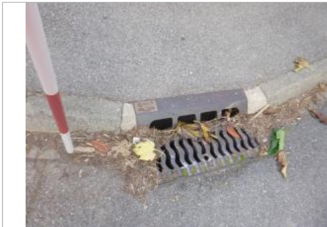
Berge rive droite - Photo ©AGERIN
