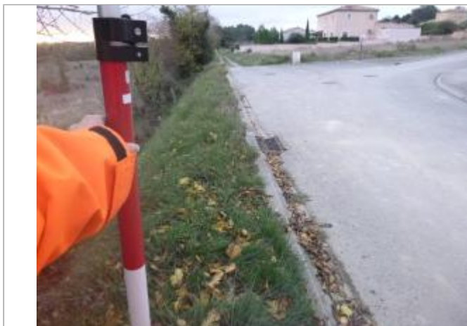
Berge rive droite fossé - Photo ©AGERIN
