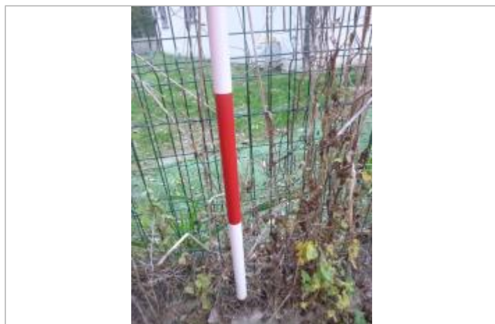
Berge rive droite digue - Photo ©AGERIN
