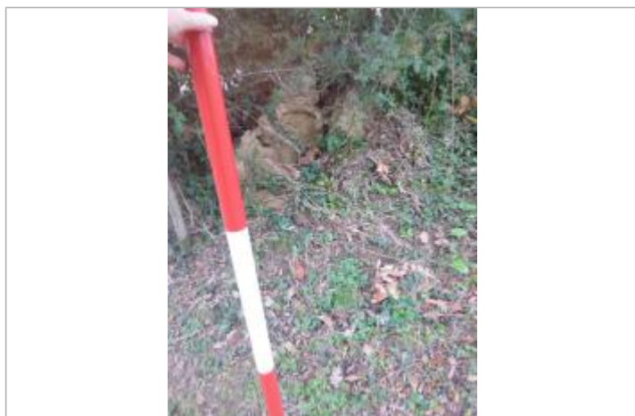
Berge rive droite - Photo ©AGERIN
