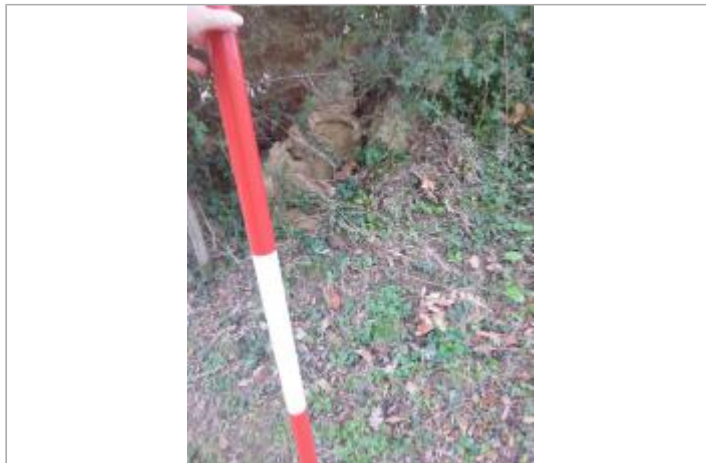
Berge rive droite - Photo ©AGERIN
