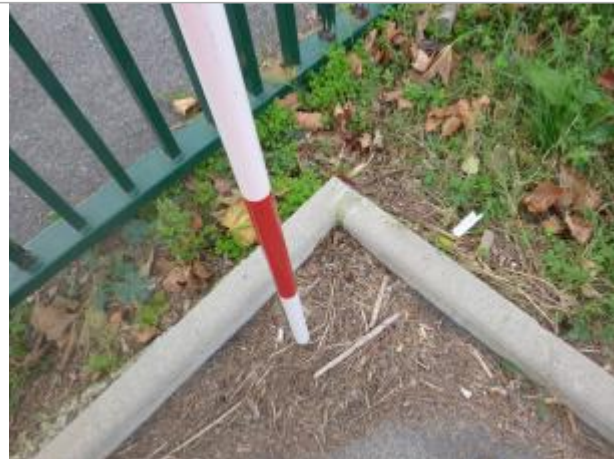
Berge rive droite - Photo ©AGERIN
