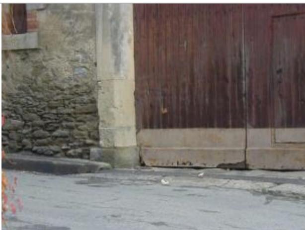
Berge rive droite - Photo ©AGERIN
