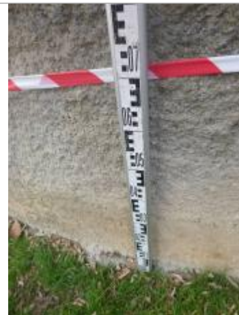
Berge rive droite - Photo ©AGERIN
