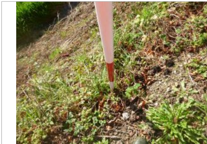
Berge rive droite - Photo ©AGERIN
