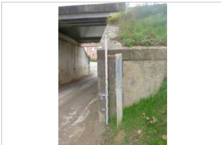
Berge rive droite - Photo ©AGERIN
