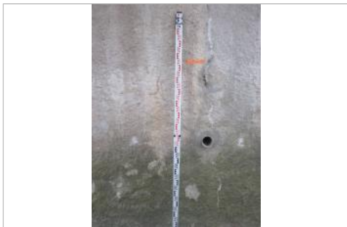
Berge rive droite - Photo ©AGERIN
