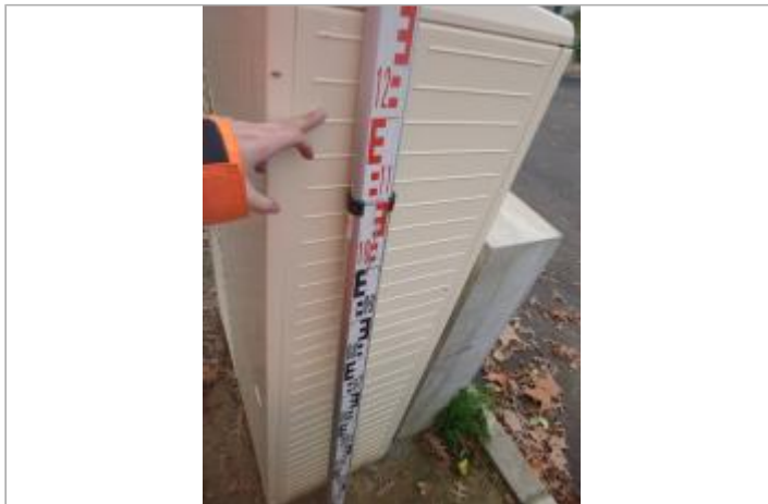
Berge rive droite - Photo ©AGERIN
