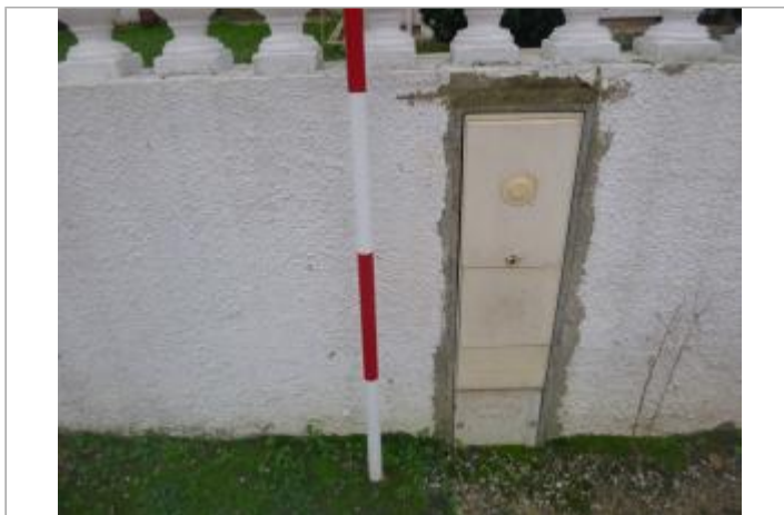
Berge rive droite - Photo ©AGERIN
