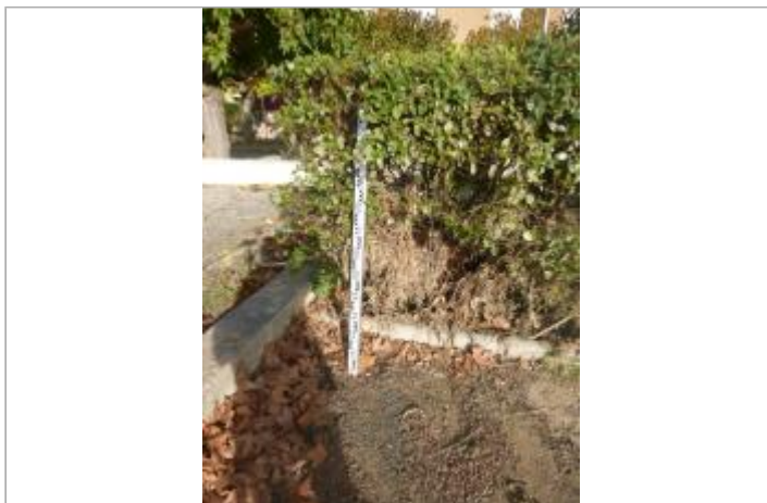
Berge rive droite - Photo ©AGERIN
