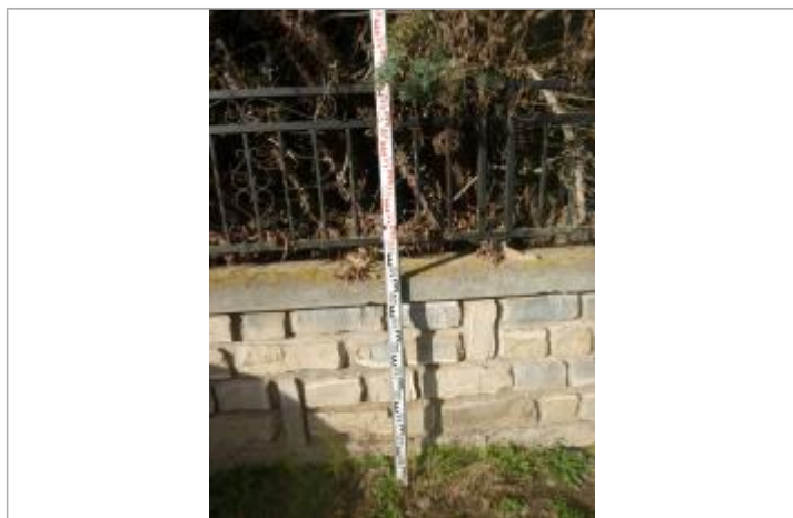
Berge rive droite - Photo ©AGERIN
