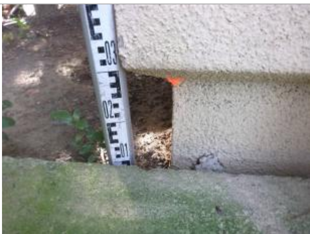
Berge rive droite - Photo ©AGERIN
