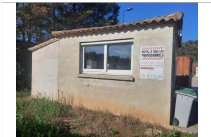
Berge rive droite - Photo SMMAR
