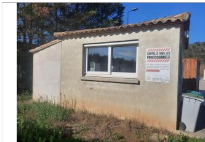
Berge rive droite - Photo SMMAR
