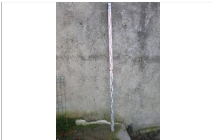
Berge rive droite - Photo ©AGERIN
