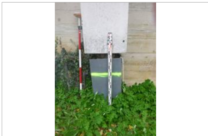
Berge rive droite - Photo ©AGERIN
