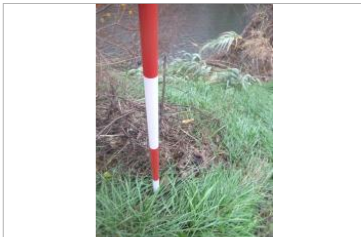
Berge rive droite amont - Photo ©AGERIN
