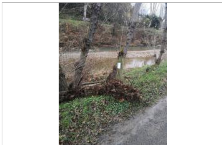
Berge rive droite - Photo ©AGERIN
