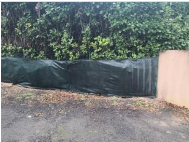
Berge rive droite - Photo ©AGERIN
