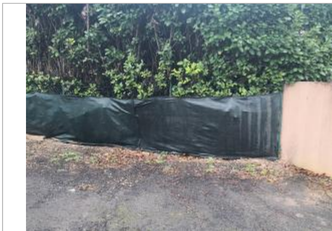
Berge rive droite - Photo ©AGERIN
