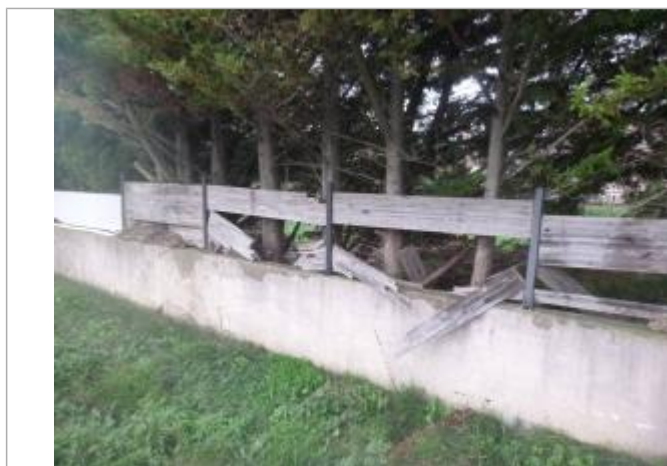
Berge rive droite - Photo ©AGERIN
