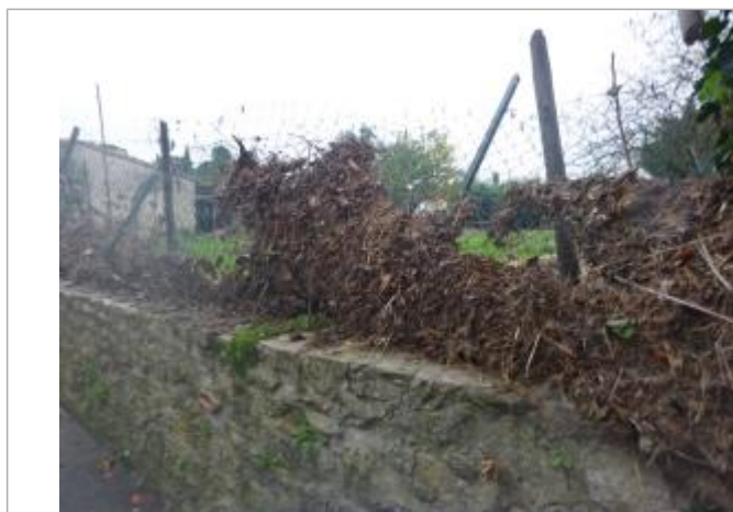
Berge rive droite - Photo ©AGERIN
