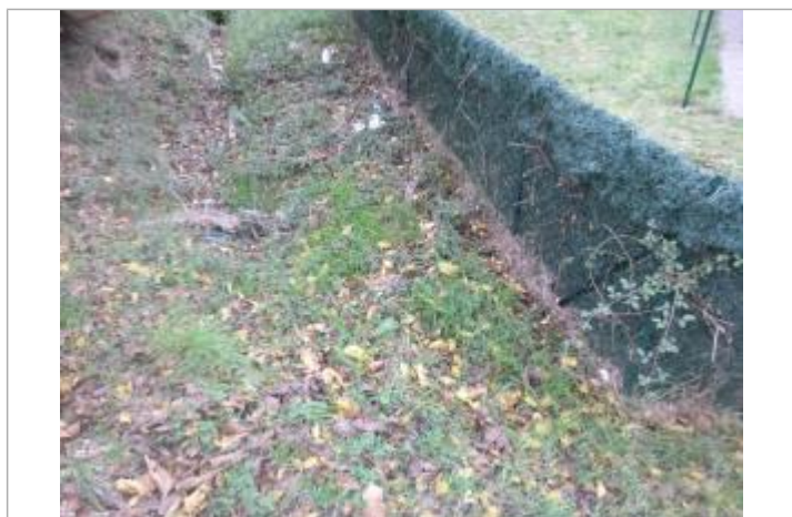
Berge rive droite - Photo ©AGERIN
