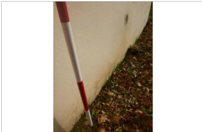
Berge rive droite - Photo ©AGERIN
