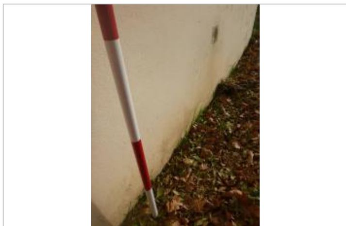
Berge rive droite - Photo ©AGERIN
