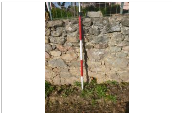
Berge rive droite - Photo ©AGERIN
