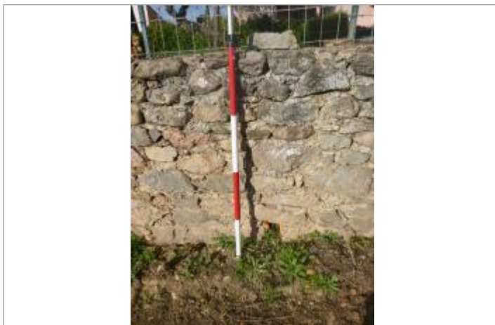
Berge rive droite - Photo ©AGERIN
