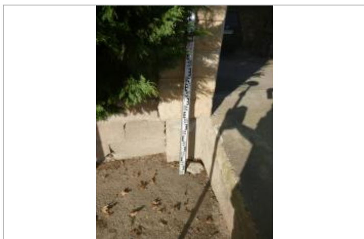
Berge rive droite - Photo ©AGERIN
