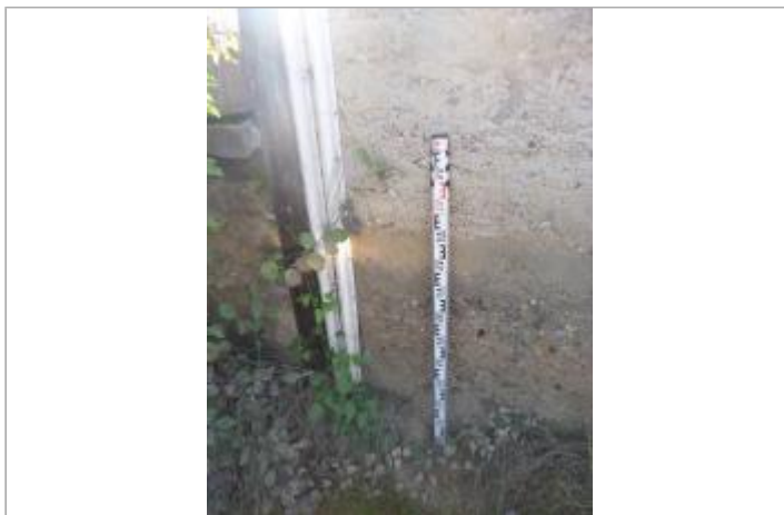
Berge rive droite - Photo ©AGERIN
