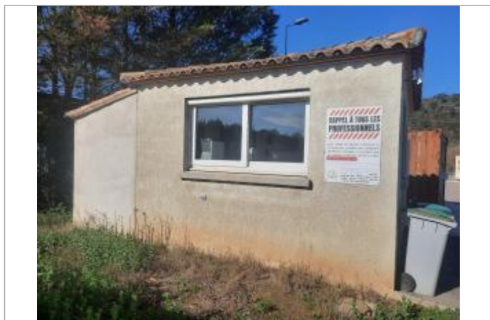
Berge rive droite - Photo SMMAR
