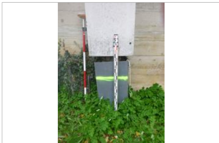
Berge rive droite - Photo ©AGERIN
