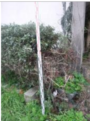
Berge rive droite - Photo ©AGERIN
