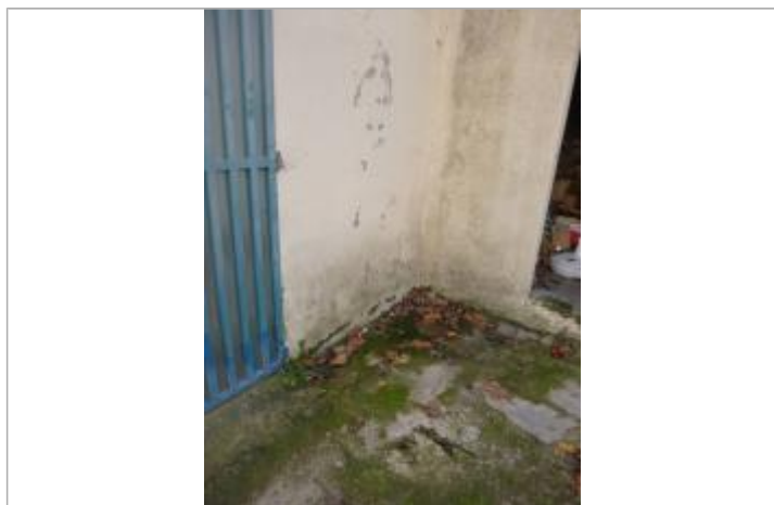
Berge rive droite amont - Photo ©AGERIN
