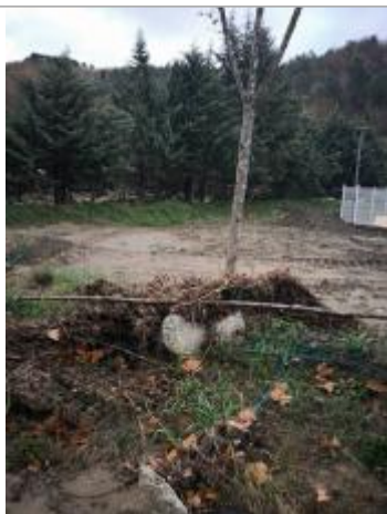
Berge rive droite - Photo ©AGERIN
