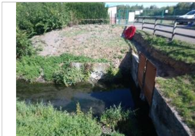
Repère de crue en rive droite de la Loisne
