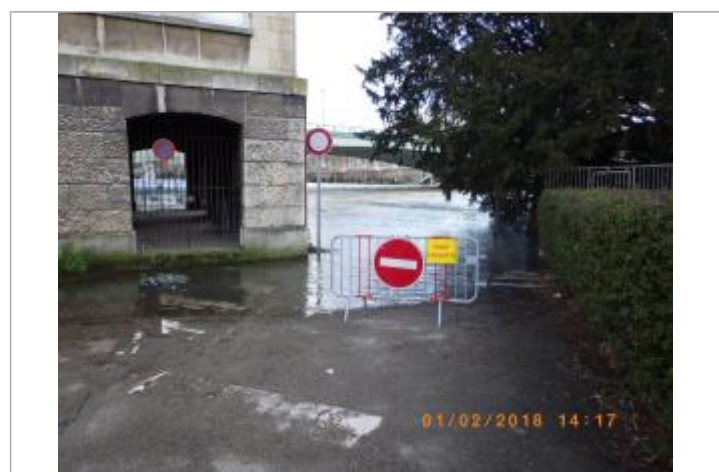
vue du niveau de l'eau au coin sud-est du bâtiment
