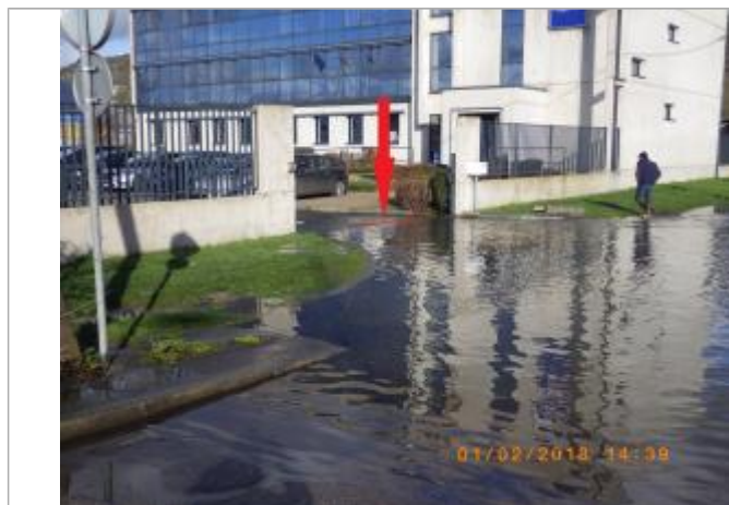
L'eau a atteint l'entrée de la cour.
