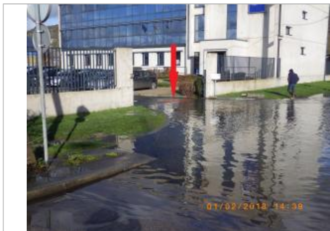
L'eau a atteint l'entrée de la cour.
