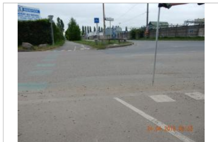
niveau atteint par l'eau sur la rue blaise pascal (photo SPC SACN)
