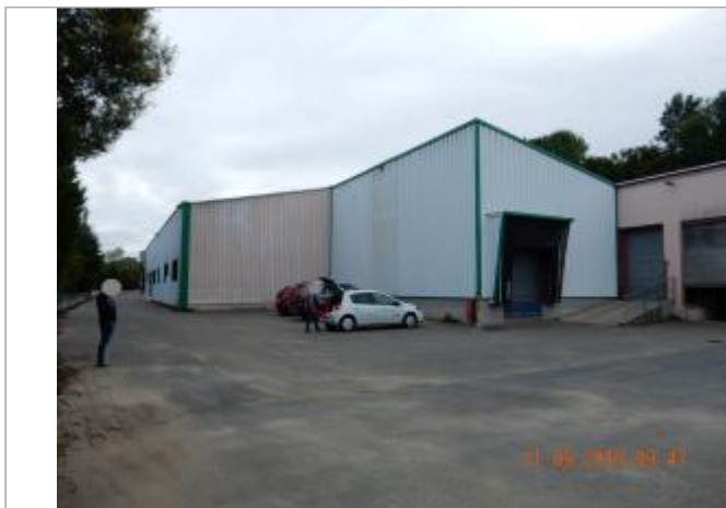
31 rue henri Papin (cours de l'usine Roselier)
