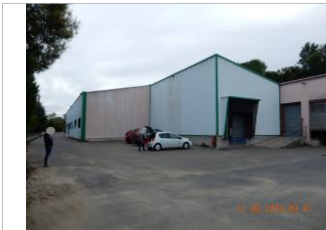
31 rue henri Papin (cours de l'usine Roselier)
