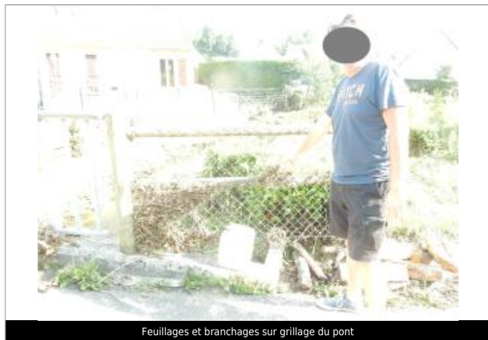
Feuillages et branchages sur grillage du pont
