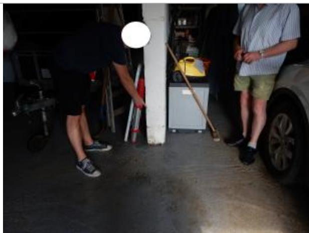
Laisse de crue à 21 cm/sol
